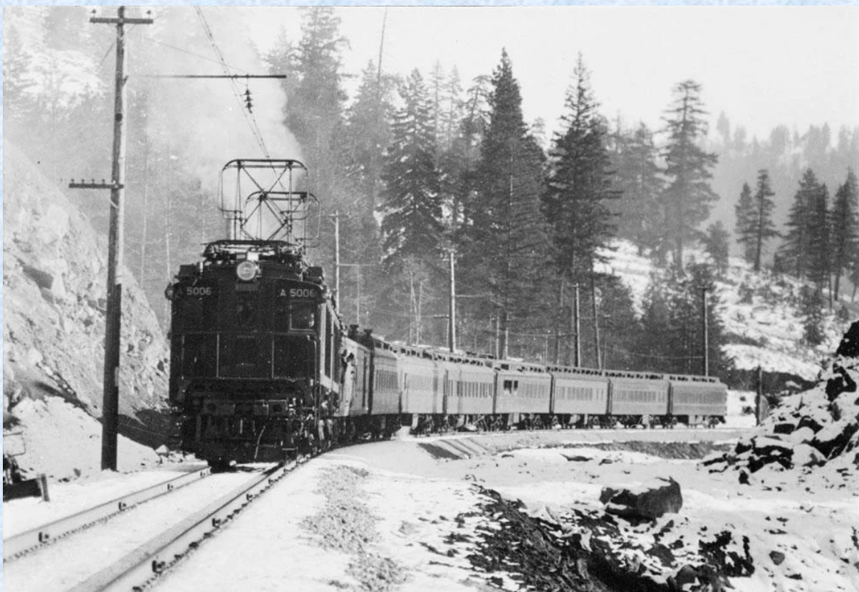
207. kép: visszatérve a Z sorozathoz, ezen a képen az 5006-os sziámi iker egy nyolc kocsis személyvonatot vontat télvíz idején. Akkorra teljesítményt nyújt, mint két szinkronba kapcsolt V42-es, kicsi erősebb is.
