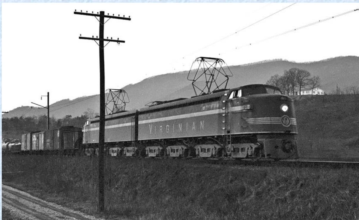
204. kép: a Ward Leonard mozdonyok non plus ultrája a Virginian EL2B-je. 16 vontatómotor és négy dinamó. 6800 lóerős ez a dög. Tom Sink gyűjteményéből.
