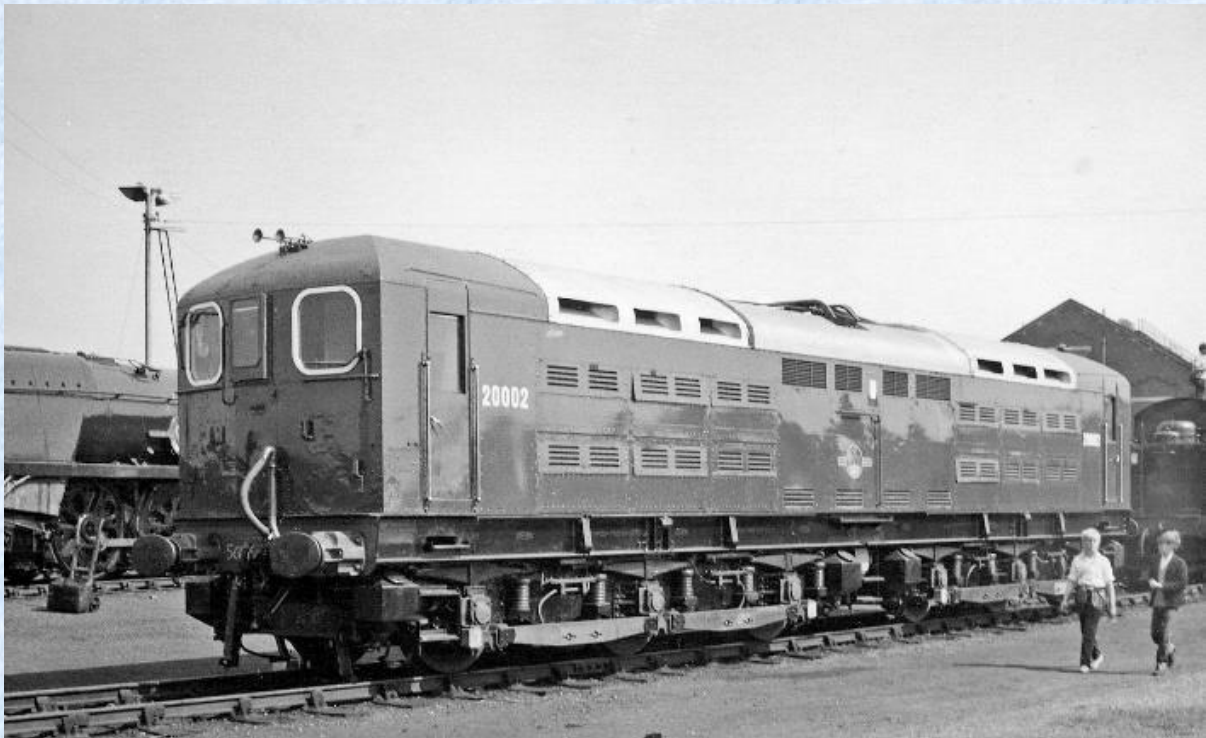
221. kép: a briteknek is volt forgóátalakítós egyenáramú mozdonyuk, a Class 70-es. Két gépcsoportja volt, 3-3 motor sorba volt kötve, úgy kapcsolódott a dinamókhoz. Ben Brooksbank felvétele.
