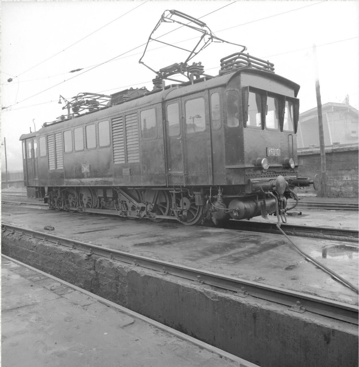
V60 001 felkészítés közben, a hosszú tömlőn át töltik fel a főlégtartályt, hogy egyáltalán üzembe lehessen helyezni a gépet. Sokat állhatott, hogy minden levegője elszökött. Háttérben a Népstadion. Közlekedési Múzeum fotó 10803
